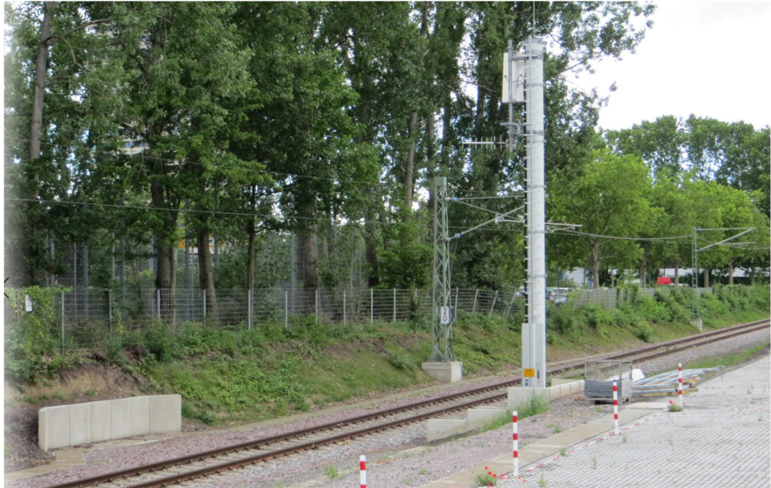
Abbildung: Kabelkanalanlagen und Funkmast DB-Strecke Nr. 3405, daneben befestigter Rettungsplatz DB AG
