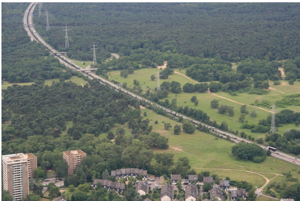
Abb. 2: Vorhandene A 643 im Erdbaubereich Oben: AS Mainz-Gonsenheim und Überführung Militärstraße Unten: Stadtteil Mainz-Mombach
