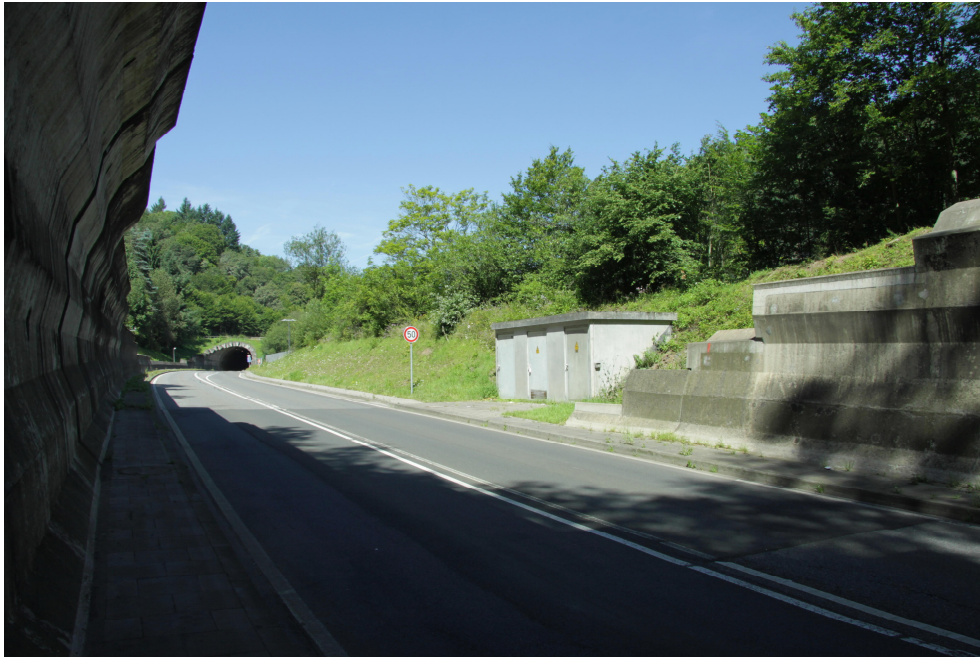
Abbildung 2: Blick aus Apollo-Tunnel in Richtung Diana-Tunnel und Trafostation
