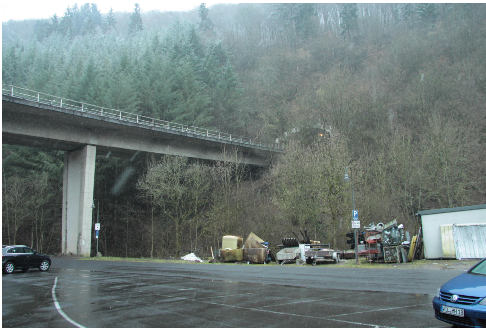
Abbildung 7: Blick auf Brücke über den Ueßbach zum Ost-Portal Apollo-Tunnel
