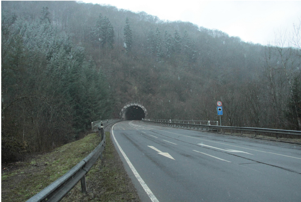
Abbildung 6: Blick auf Brücke über den Ueßbach zum Ost-Portal Apollo-Tunnel
