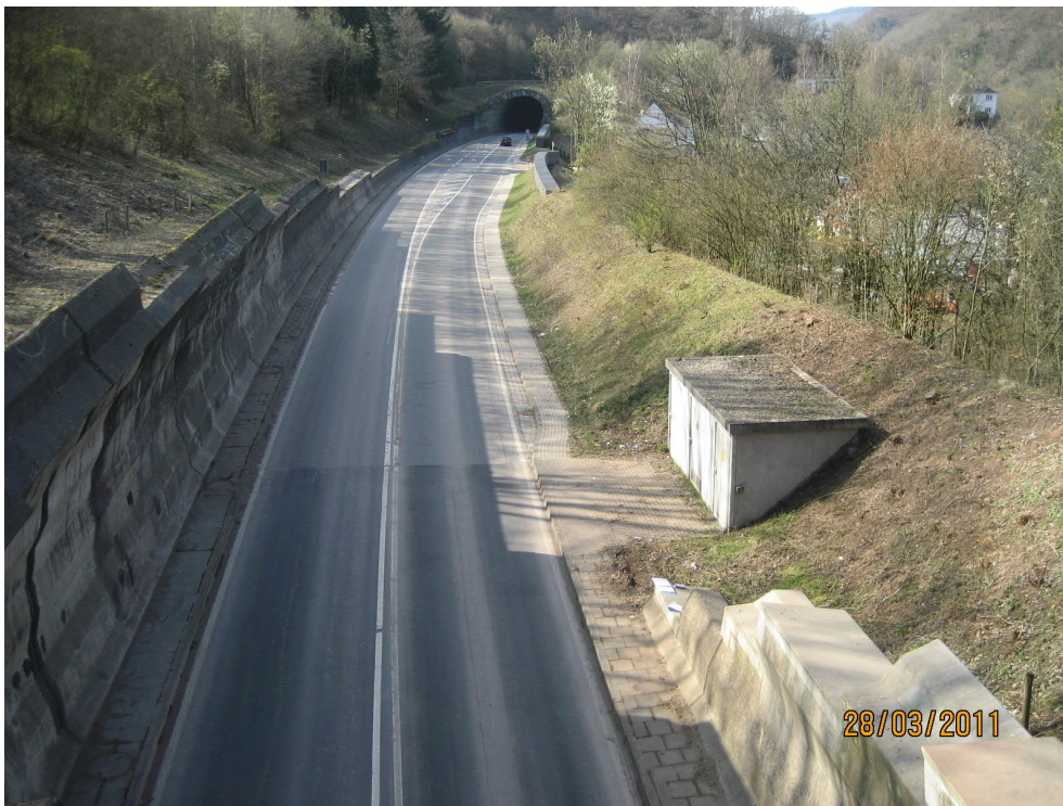
Abbildung 3: Blick vom West-Portal des Apollo-Tunnels auf Freistrecke
