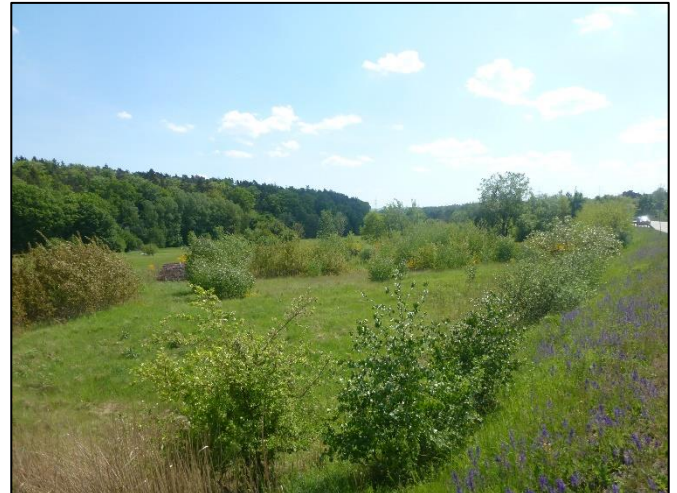
Bild: Rückhaltebecken mit Gehölzaufwuchs Anfang Mai 2022
