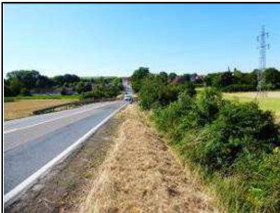
Blick nach Friesenheim bei Bau-km 0+240
