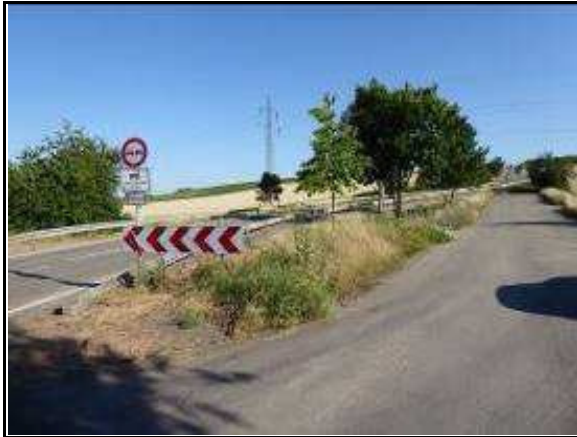
Blick auf die Verschwenkung bei Bau-km 0+080
