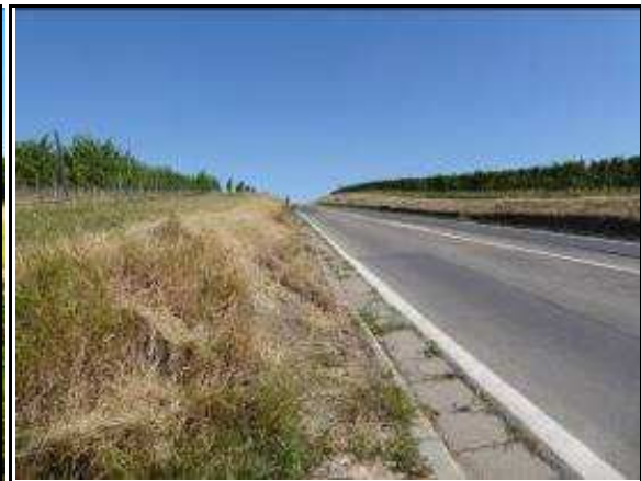
Sicht auf die Seitenräume der L425 nördlich des betroffenen Bauabschnittes (Blick nach Norden)
