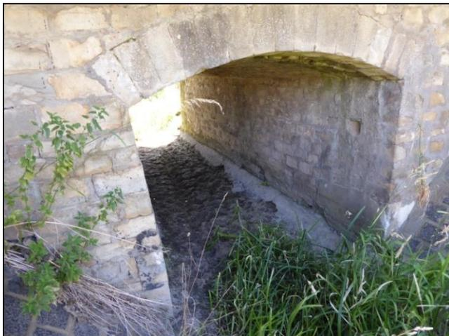
Gemauertes Brückenbauwerk als Durchlass des Dalheimer Flutgrabens unter der alten L425
