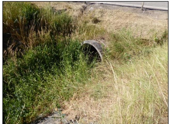
Rohrdurchlass (Beton) des Dalheimer Flutgrabens, unter der bestehenden Verschwenkung der L425
