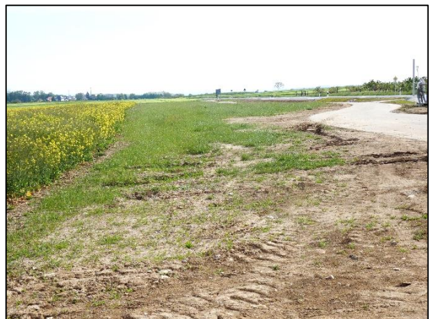
Noch nicht fertiggestellte Ausgleichsfläche im Seitenraum der L426
