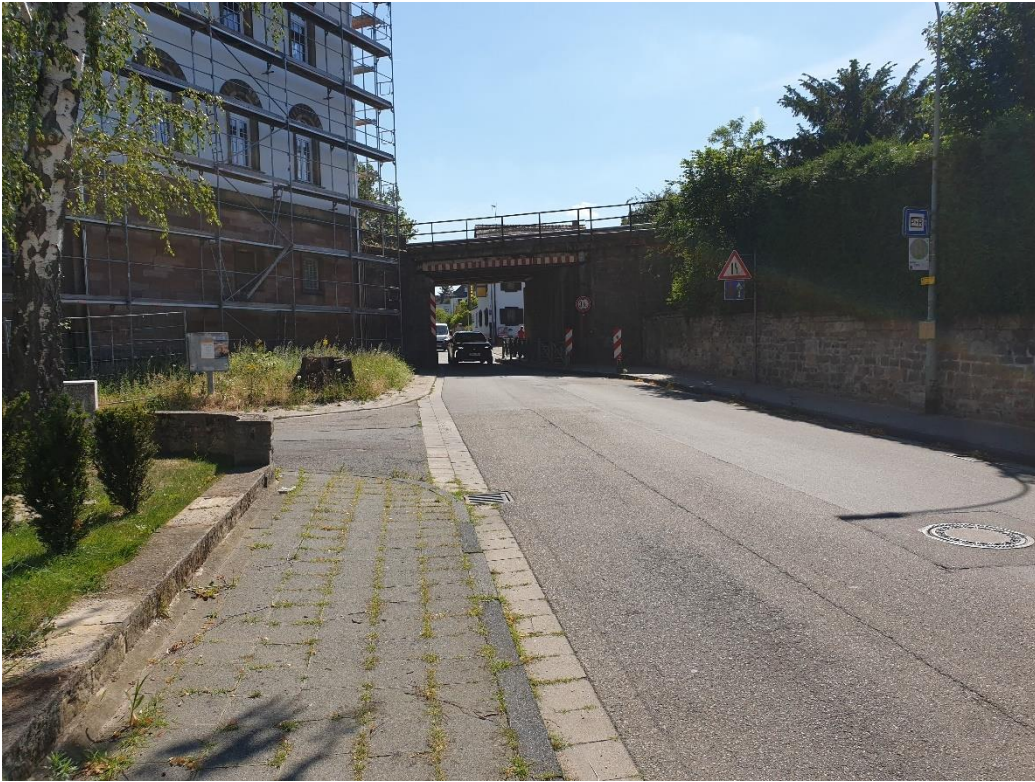
Bild 5, altes Bahngebäude in Richtung Bauwerk
