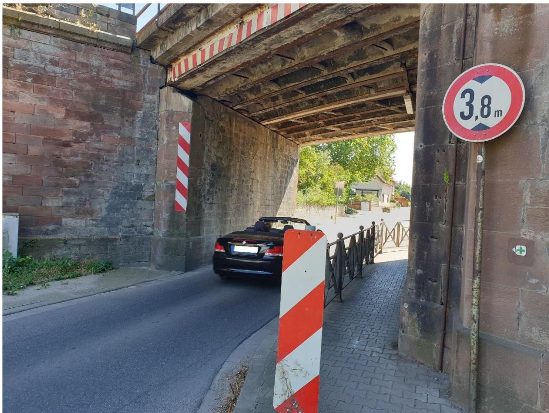
Bild 3: Zufahrt Brückenbauwerk Nordseite
