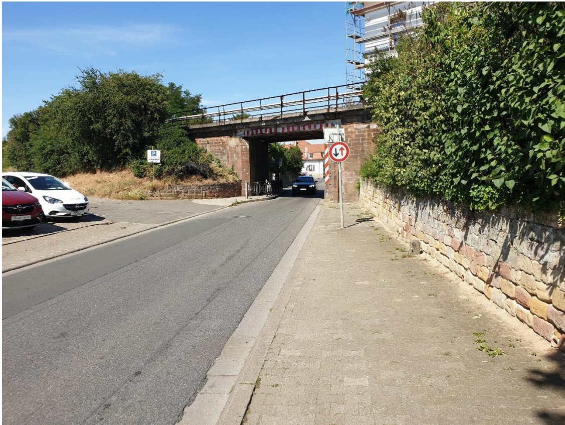
Bild 2: Zufahrt Brückenbauwerk Südseite
