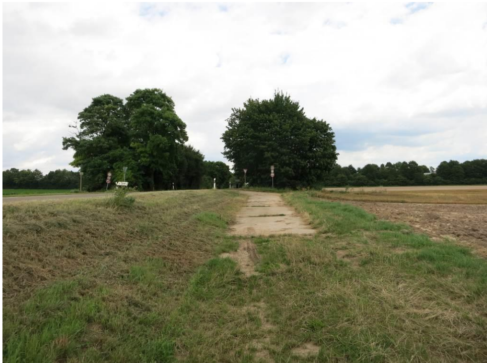
Abbildung 5: Gehölze im Bereich der Einschnittböschung vor der Autobahn, im Hintergrund die Gehölze entlang der Autobahn, Blickrichtung Osten
