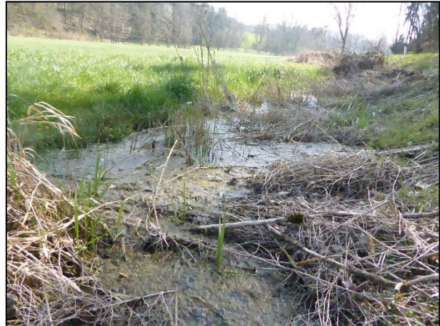
Abb. 25: Wasserführende, tümpelartige Fläche bei einem Durchlass bei Bau-km 1+620
