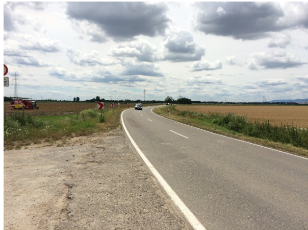
Blick über die L 524 nach Süden im nördlichen Bereich
